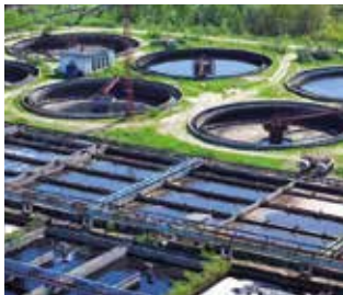
IMPIANTI DI DEPURAZIONE
